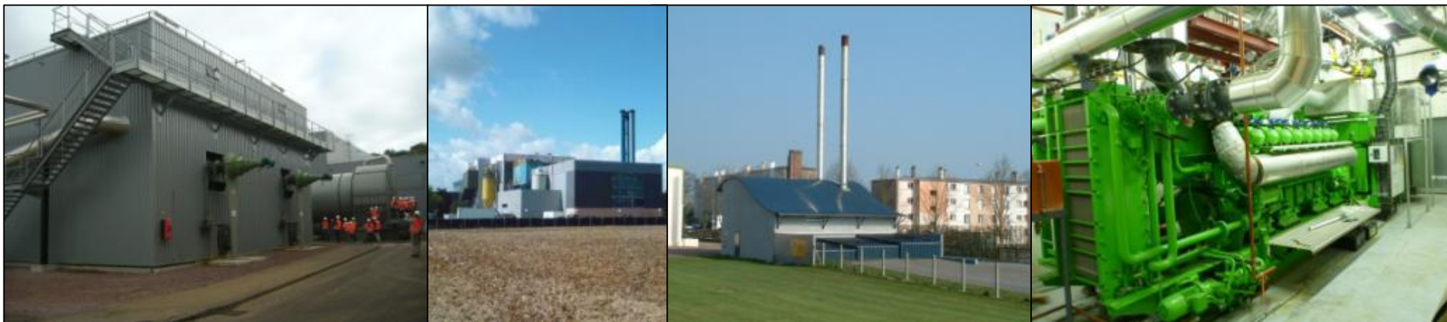
Unité de méthanisation de Cavigny (50), SIRAC à Colombelles (14), Réseau de chaleur de la Ferté Macé (61), Unité de cogénération de COGESTAR à Caen (14) – Source : OBNEC
